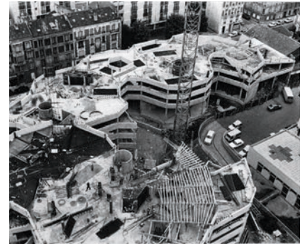
Building site of Le Liégat.
