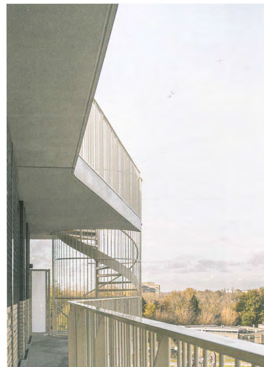
Ook de vluchtrappen zijn opgenomen in de golfing van de galerij.
