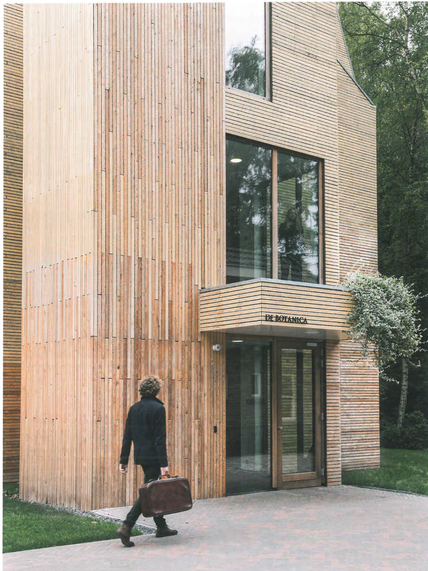
De gevel van onbehandeld larikshout zal langzaam vergrijzen.
