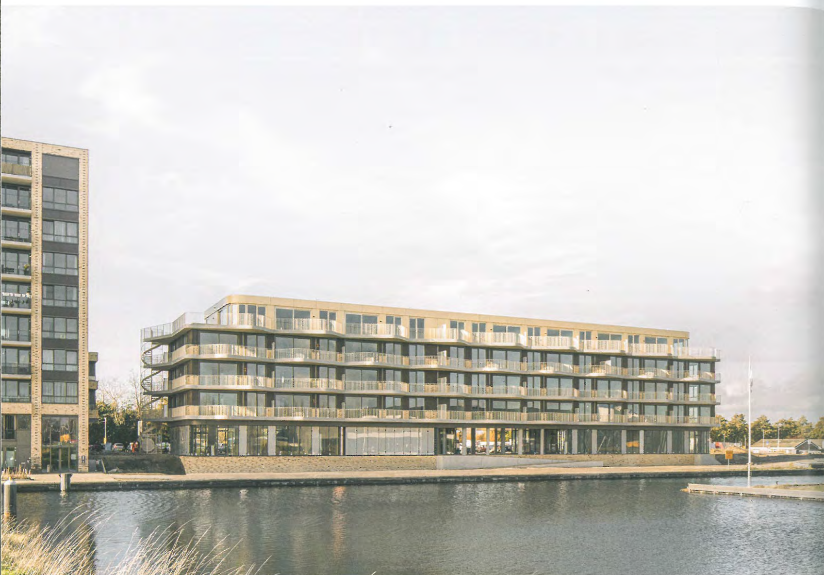
Onder het tweede bouwblok is een transparante plint gemaakt met commerciële voorzieningen en een onderdoorgang.
