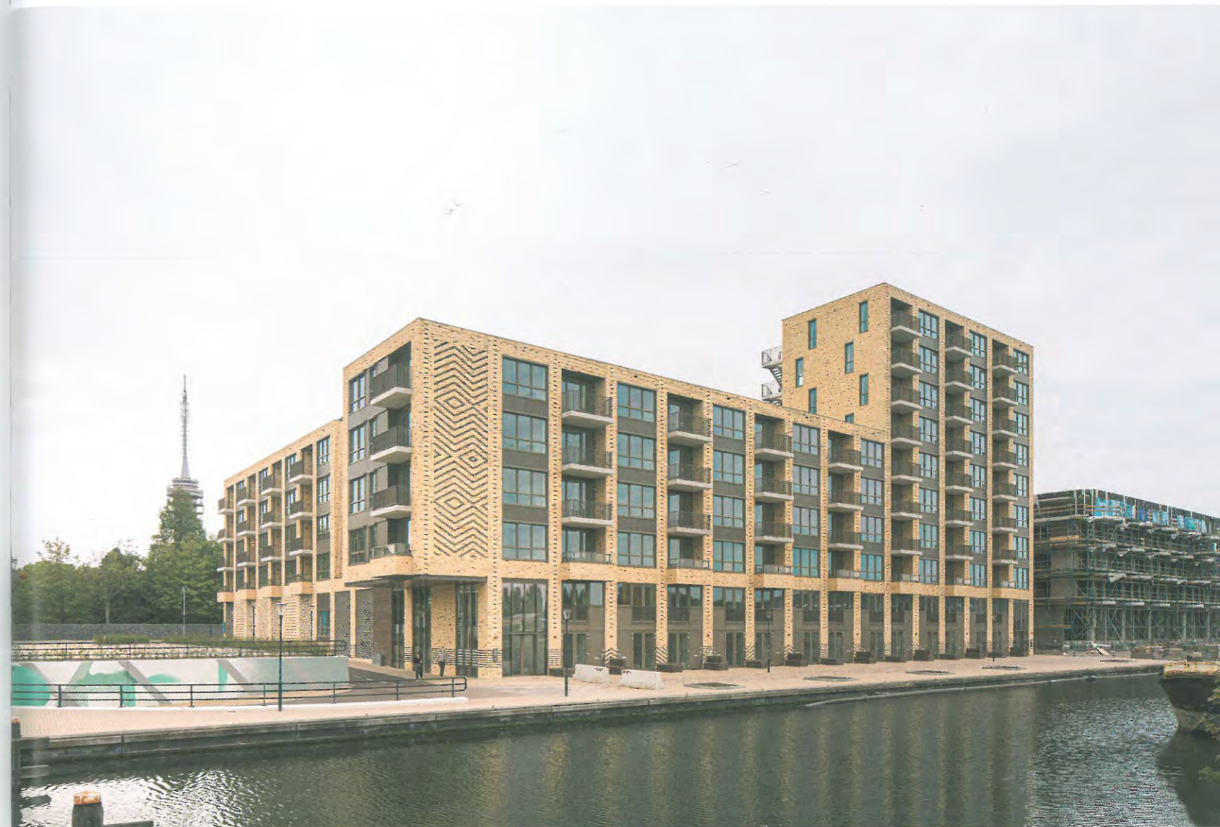
Kadewoningen van het eerste bouwblok zorgen voor direct contact met de boulevard.
